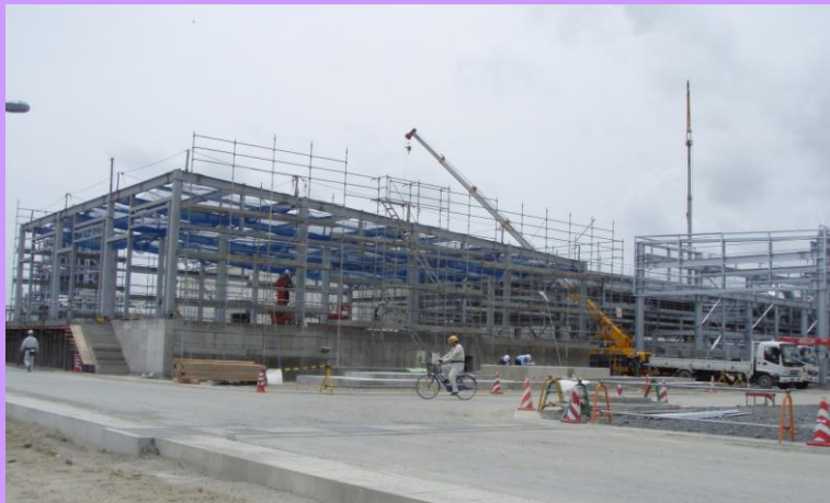
(エムセテック相馬工場 現場状況)
